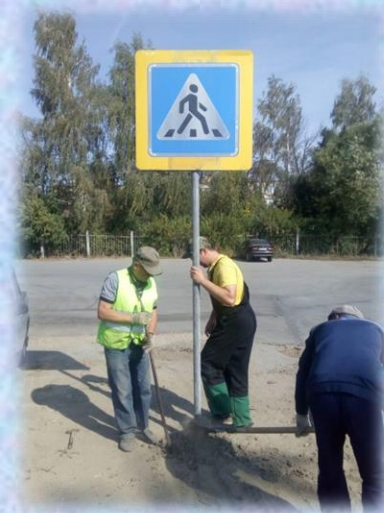
Установка дорожных знаков
