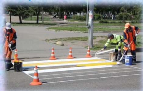
Нанесение дорожной разметки
