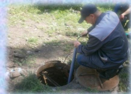
Очистка канализационных сетей
