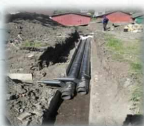
Капитальный ремонт котельной «Середейский»
