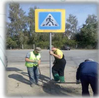
Установка дорожных знаков
