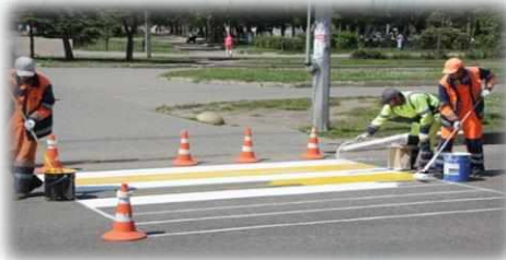
Нанесение дорожной разметки
