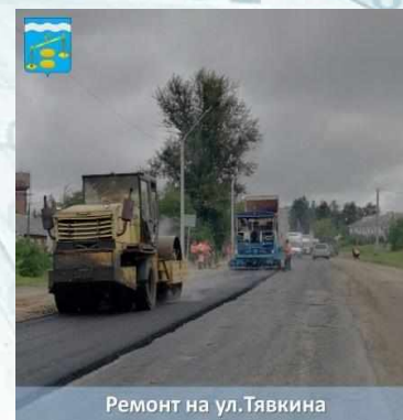
Ремонт на ул.Тявкина
