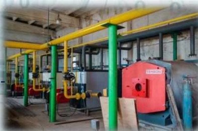
Техническое перевооружение котельной СМУ-11
