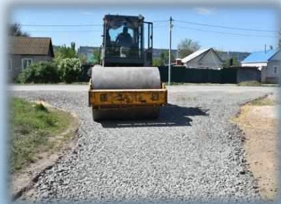
Ремонт автодорог в щебеночном исполнении
