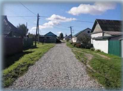
Ремонт автодорог в щебеночном исполнении
